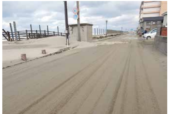
国道 112 号に堆積した砂
