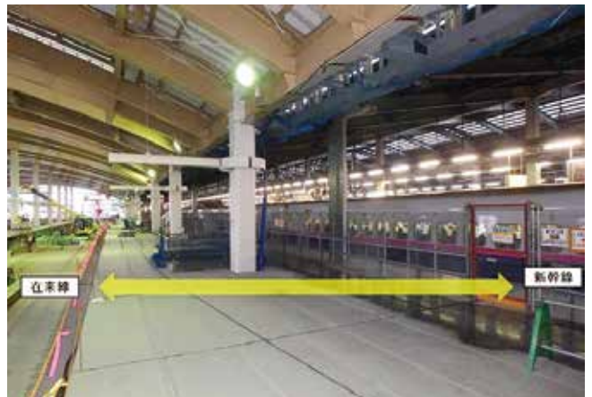
新潟駅新幹線在来線同一ホーム事業工事 (本年 1 月 6 日撮影、新潟市 HP より)
