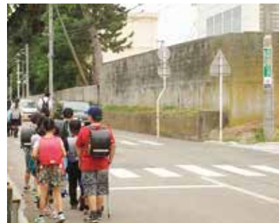
撤去前のブロック塀
