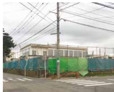
撤去工事の様子
